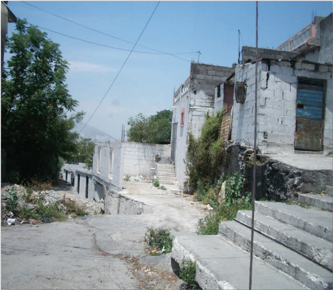
En el polígono Independencia, vehículos y peatones transitan por calles irregulares, lo que dificulta el acceso a las viviendas.
